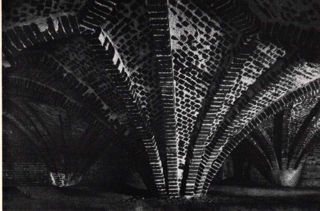
29 Marienburg, Kellergewölbe unter dem Großen Remter im Hochmeisterpalast
