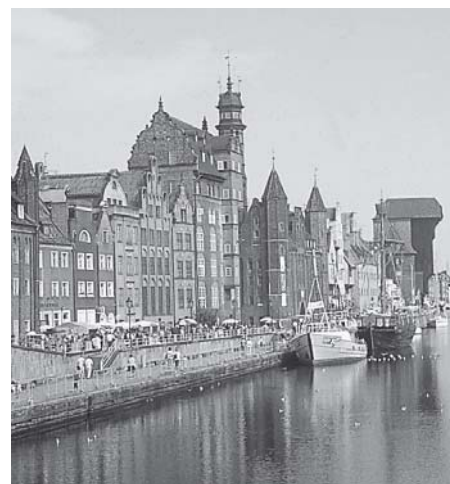
Lange Brücke, Wiederaufbau (1993).
