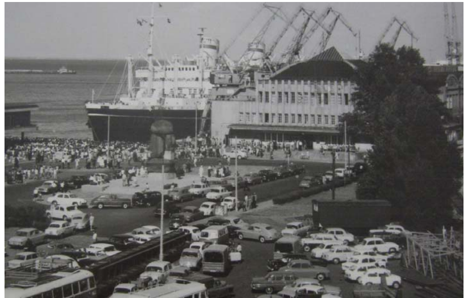
■ Der so genannte „Dworzec Morski“ in den 60er-Jahren. Exponat im Emigrationsmuseum, welches sich heute in dem Gebäude befindet.
